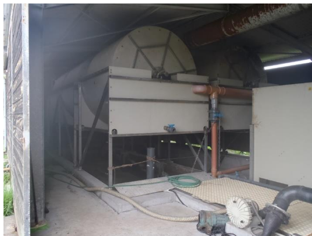
Figure 2.3-Batteries de biodisques
