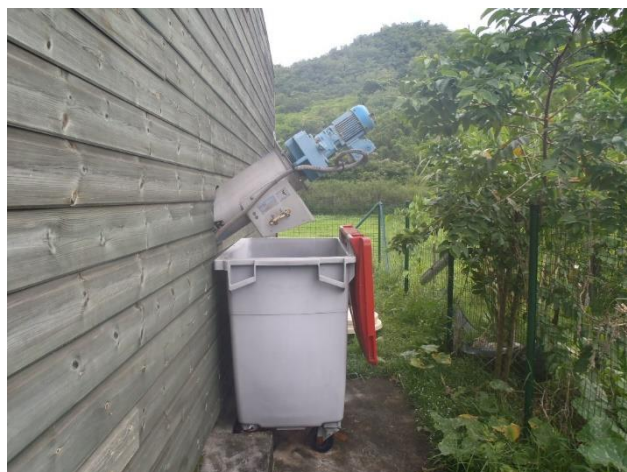
Figure 2.1-Dégrilleur
